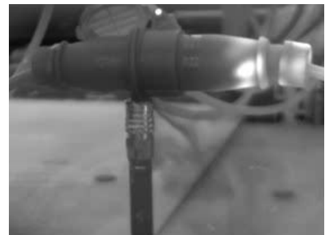
Die FLIR-Kameras der GF-Serie visualisieren unsichtbare Gase an Leckagestellen als dunkle Rauchfahnen, die im bewegten Bild besonders gut zu erkennen sind.
